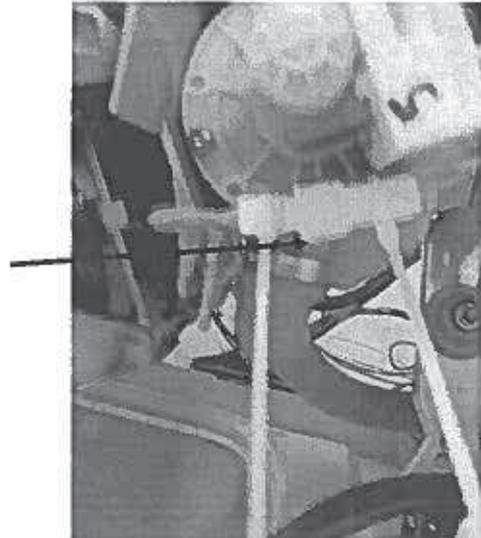
La bretelle et le boîtier de raccordement doivent être attachés sur le toron de filerie tendu entre le point de sortie sous la cuve et le crochet de maintien sur la pompe.
